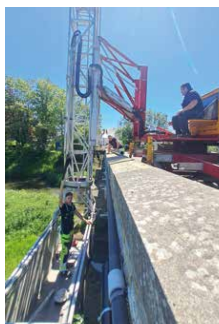
Les conduites sont fixées sur la structure du pont avant le raccordement final.
