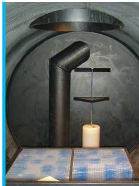
Binnenzicht afscheider: coalescentiecel + automatische afsluiter
