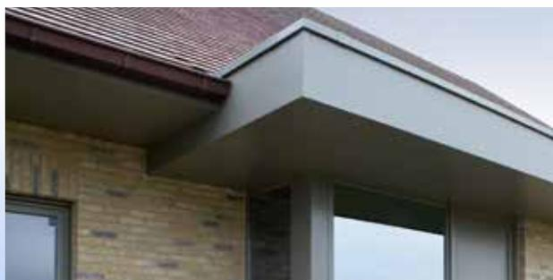
**Matériau :** PVC cellulaire avec une couche de finition en PVC rigide
