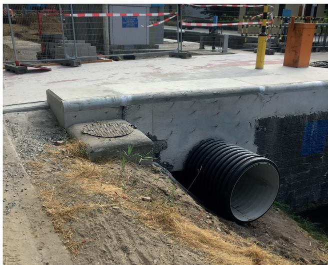
Pour ce projet, De Vlaamse Waterweg utilise de grands tubes Ribwall en polypropylène. Afin de garantir une capacité suffisante, on a choisi de placer un tube d'un mètre de diamètre. Outre le facteur économique, ce tube offre des avantages en termes de pose. Malgré sa longueur de 6 m, le tuyau
