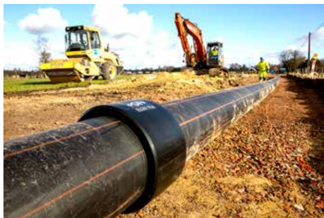
De diameter van de drukbuizen is van 250 naar 450 mm vergroot.
