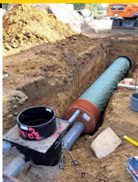
PP-Ribwall IT Riool DN800 leidingen.
