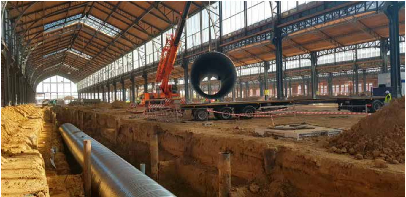
Waterafvoer is een van de vele belangrijke aandachtspunten in het nieuwe Gare Maritime.
