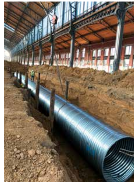
De stalen Tubao-tanks hebben een diameter van 2 meter.
