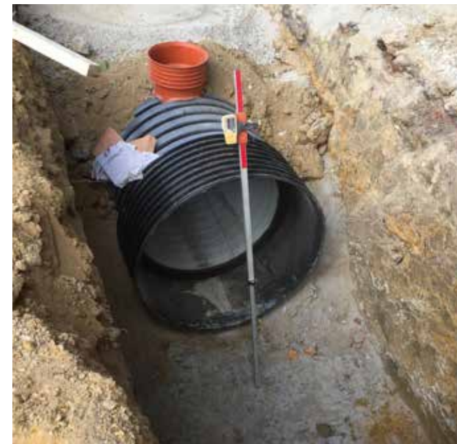
Om voldoende capaciteit te waarborgen werd gekozen om een buis met een diameter van 1 m te plaatsen.
