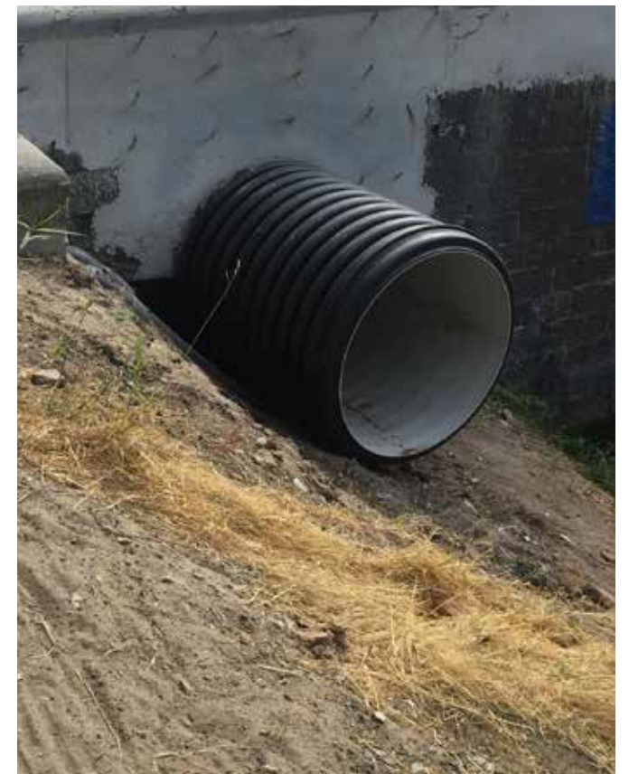
Voor een cruciaal deel van dit project viel de keuze op Deschacht als leverancier van grote Ribwall buizen uit polypropyleen.
