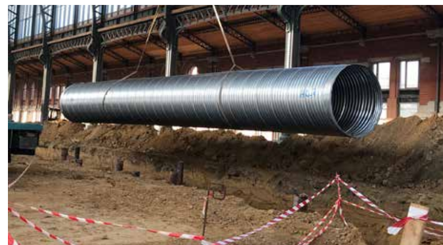
De tanks zijn elk opgebouwd uit elf stukken buis van 20 meter lang.
