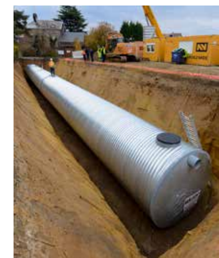
Er werd gekozen voor een gigantische 240 m 3 grote Tubao-buis van gegalvaniseerd staal.
