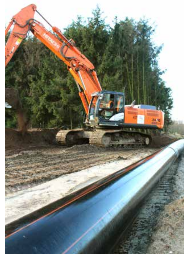
Deschacht liet de leidingen op maat produceren.
