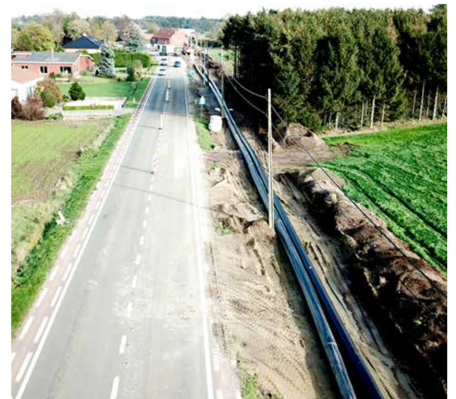
Langs het traject van het fietspad tussen Poederlee en Lichtaart wordt ook een nieuwe drukpersleiding gelegd.
