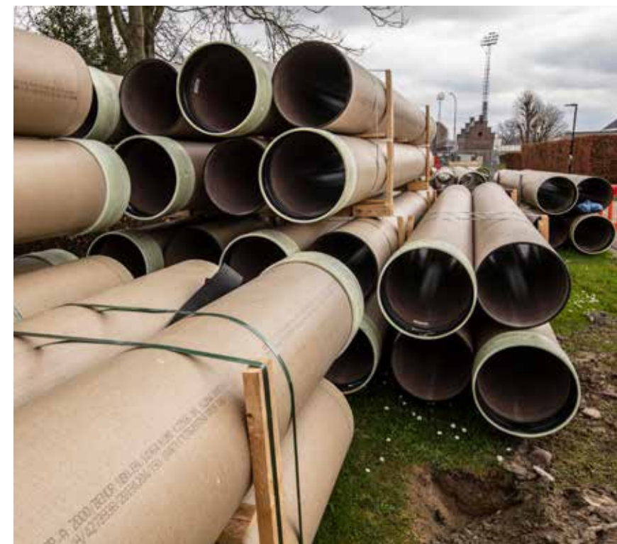
Voor de technische expertise en levering van de GVK-buizen en fittings deed Persyn een beroep op Deschacht.
