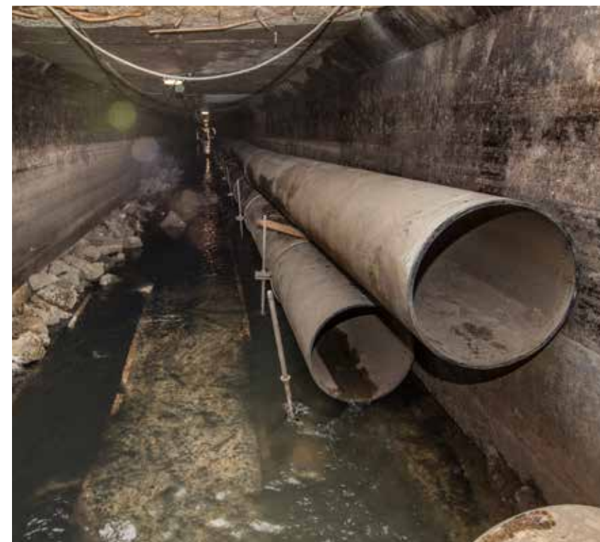
Over een afstand van 2 km werd voor de afvoer van het afvalwater een nieuwe riolering in glasvezelversterkte kunststof (GVK) geplaatst in de bestaande koker.
