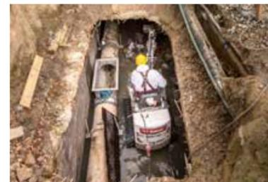
Les travaux se déroulent dans un conduit de 2 m sur 2 m, sur une longueur de 2 km.
